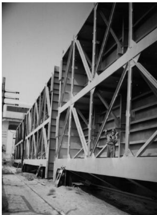
Рис. 1. Затворы здания Волжской ГЭС
