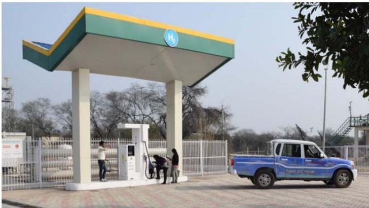
Рисунок 6. Водородная АЗС для двухтопливных автомобилей в Нью-Дели. Электролизер Ener Blue 5 Нм<sup>3</sup>/час 10 бар.
