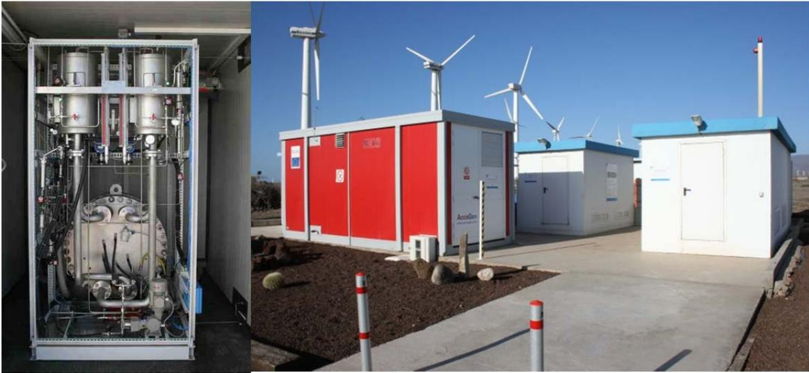
Рисунок 3. Ветер для водородной системы на Канарских островах. Водород преобразуется обратно в электрическую энергию с помощью топливных элементов. Электролизер Ener Blue 10 Нм<sup>3</sup>/ч 30 бар.
