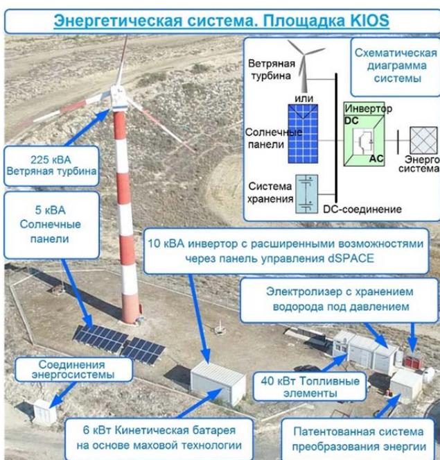
Рисунок 1. Ветер для водородной системы на острове Кипр. Водород преобразуется обратно в электрическую энергию с помощью топливных элементов. Электролизер Ener Blue 10 Нм<sup>3</sup>/ч 30 бар.
