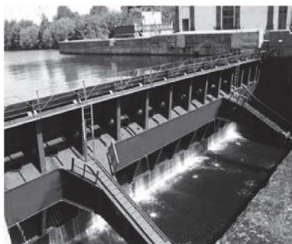
Рис. 4. Конструкция несущей части затвора
