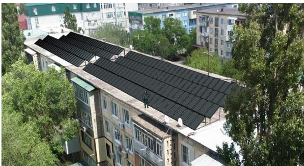
Рис.1. Вариант перевода 5-ти этажных жилых домов города Махачкала на солнечные водонагревательные коллекторы
