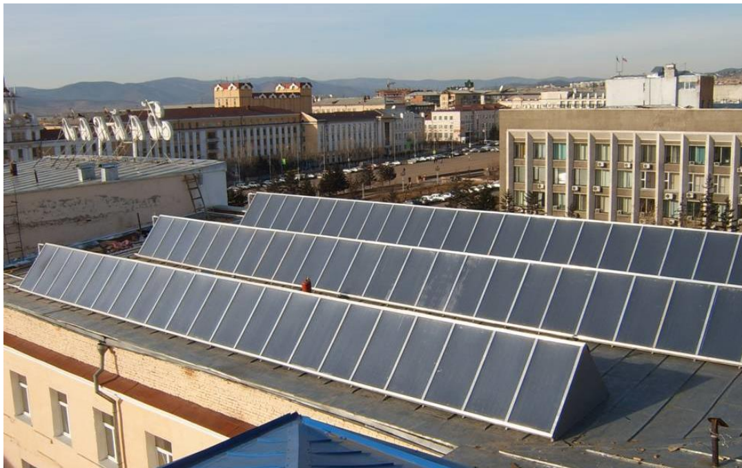
Рисунок 4 - Гелиоустановка гостиницы «Байкал» в г. Улан-Удэ
