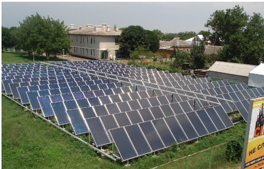
Рисунок 3 – Гелиоустановка больничного комплекса г. Усть-Лабинска
