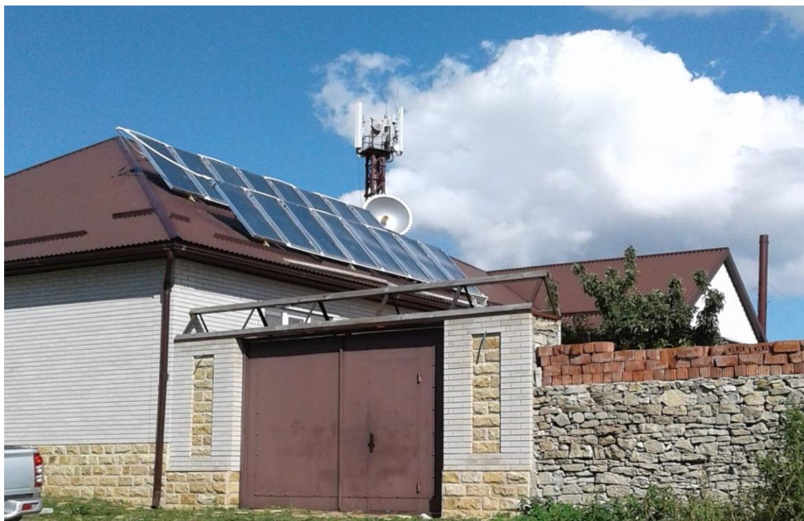
Рис.1. Солнечная водонагревательная установка жилого дома в Хунзахе
