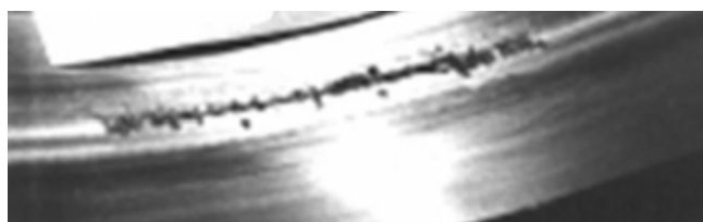
Рис. 4. Разрушение рабочей поверхности
