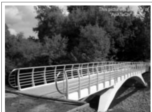
Рис. 4. Арочный мост из полимерного композиционного материала Arched bridge made of polymer composite material
