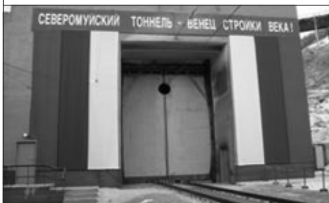
Рис. 11 Ворота из полимерных композитов для Северомуйского железнодорожного тоннеля
